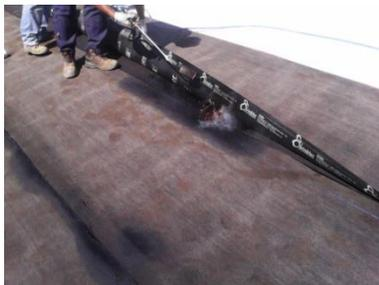
Le falde di copertura saranno impermeabilizzate mediante guaine bituminose ardesiate e non, di spessore 3 - 4 mm, fiammate e sigillate a caldo mediante cannello a gas, posate sopra lo strato isolante catramato, o direttamente sopra il rustico del solaio previa spalmatura di primer bituminoso per facilitare l'adesione.
