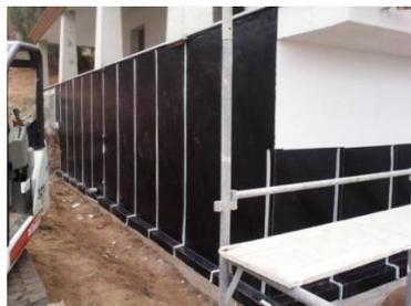
I muri controterra, verranno impermeabilizzati mediante guaine bituminose a freddo, autoadesive, tipo SATHUTENE 3000, autovulcanizzanti, e protetta da una membrana bugnata drenante per tutta l'altezza dell'interrato. In alternativa sarà possibile l'applicazione di poliuree a spruzzo. Alla base della parete verranno stesi adeguati tubi di drenaggio microforati, ricoperti in ghiaino, per garantire un adeguato deflusso delle acque.
