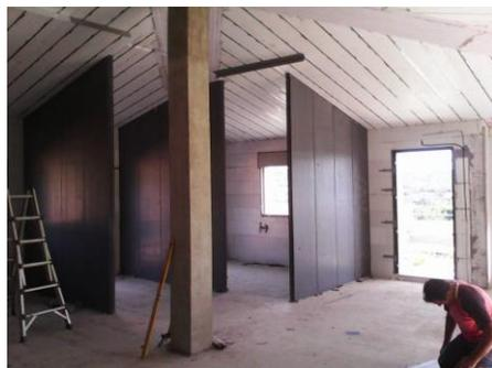
Parete divisoria interna antisismica, estremamente leggera ed elastica, creata al fine di eliminare la possibilità di distacco strutturale in caso di sollecitazione sismica sull'edificio, in eps da 25 kg/ mc di densità, spessore 10 cm. All'interno dei pannelli sono posizionati 2 profili metallici ad interasse di 30 cm, in lamiera zincata di spessore 6/10 di mm e sagomati a C.
