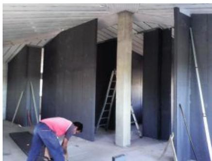
Parete divisoria interna antisismica, estremamente leggera ed elastica, creata al fine di eliminare la possibilità di distacco strutturale in caso di sollecitazione sismica sull'edificio, in eps da 25 kg/ mc di densità, spessore 8 cm. All'interno dei pannelli sono posizionati 2 profili metallici ad interasse di 30 cm, in lamiera zincata di spessore 6/10 di mm e sagomati a C.
