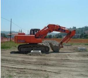
Gli scavi dipendono essenzialmente dalla natura stessa del terreno e non è possibile generalizzare, nella valutazione dell'offerta, abbiamo ipotizzato un terreno pianeggiante, prossimo alla sede viaria, con consistenza idonea alla realizzazione dell'edificio senza dover scavare oltre i 50 cm e senza la presenza di roccia, restando escluso quanto necessario per la formazione della fognatura, dei cunicoli per condutture e rete impianti.
