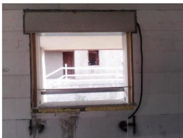
In corrispondenza delle aperture, verranno posizionati i monoblocco finestra tipo ALPAC o similari, composti da cassonetto coibentato, spalle coibentate, tapparella coibentata e motore a manovra elettrica. Questi verranno fissati alla struttura mediante schiuma poliuretana o tasselli.
