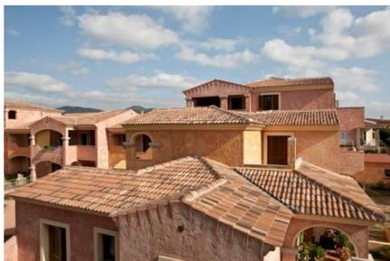
Il manto di copertura sarà realizzato mediante tegola modello COPPO MAESTRO di Sarda tegole, in colore a scelta dal cliente. Il sistema prevede la realizzazione di colmi, compluvi, e scossaline perimetrali.
