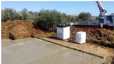
Tra il piano di scavo e le fondazioni, verrà gettato uno strato di calcestruzzo magro dello spessore di circa 8/10 cm, allo scopo di offrire una superficie compatta e livellata, atta alla posa delle strutture di base dell'edificio.
