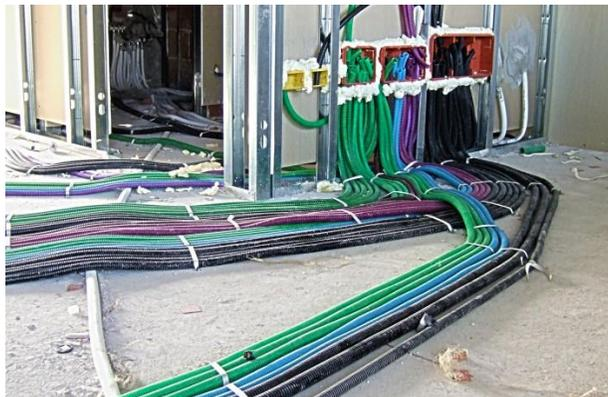
Tutti i vari impianti interni ed esterni saranno posti sottotraccia entro tubazioni protettive in P.V.C., e saranno realizzati nel rispetto delle vigenti norme C.E.I.
